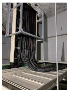
電気ケーブル架設
