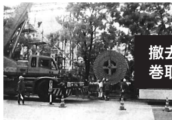
大型ドラム回しに設置→
