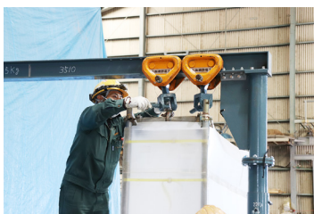
②ジャッキで調整しながら配電盤と門型クレーンをアイボルトで繋ぎます
