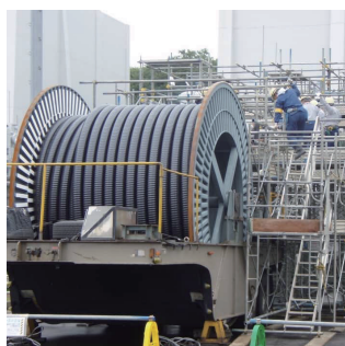
電気ケーブル架設
