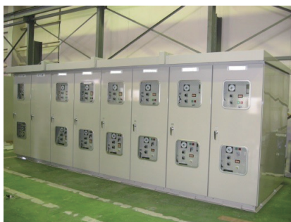
配電盤/制御盤設置
