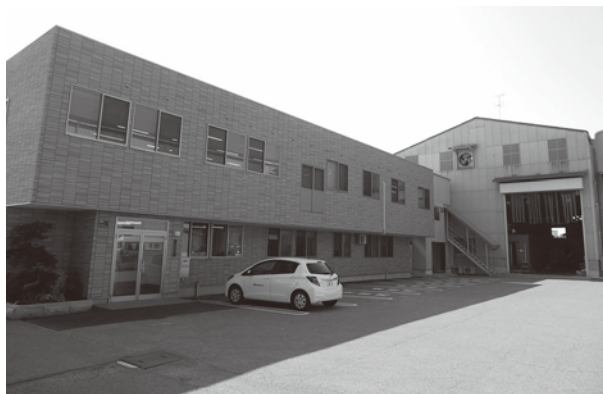
西機電装外観
